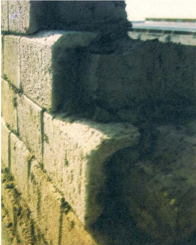
Photo 1 : Gros plan d'un mur en adobéton (la mise en oeuvre est ici approximative avec des joints de collage trop épais).
